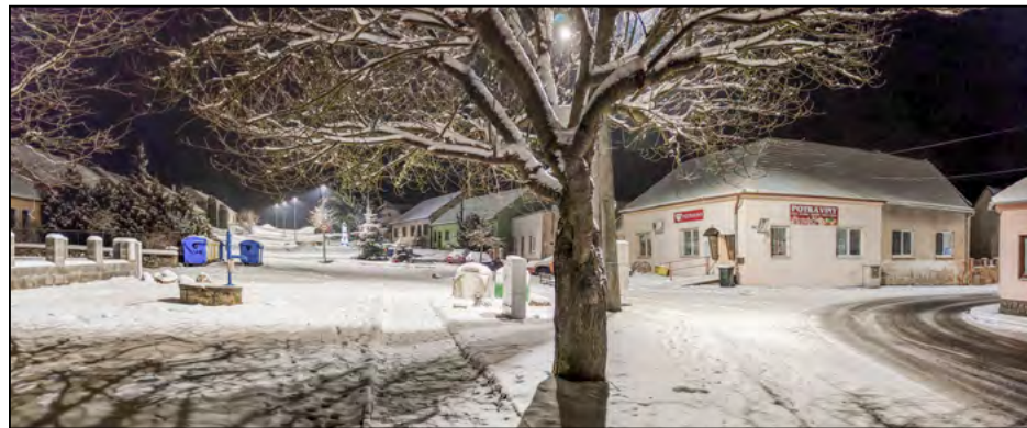
Nově osvětlený horní konec obce. Na předchozí straně nedokončený vodojem. Na titulní straně také nová světla v okolí vánočního stromu i s novým rozvaděčem a zásuvkovou skříň.
