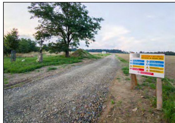
Ze stavby cesty k budoucímu vodojemu.
