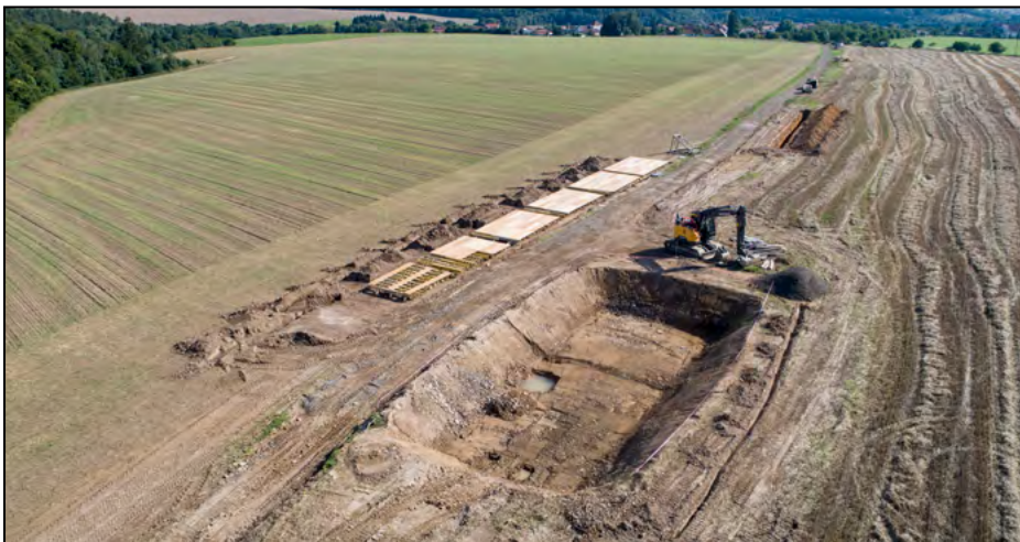
Stavba budoucího vodojemu z výšky.
