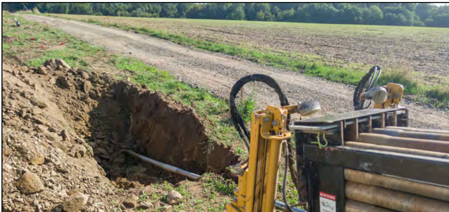
Ze stavby vodojemu. Protahovací vrtání.
