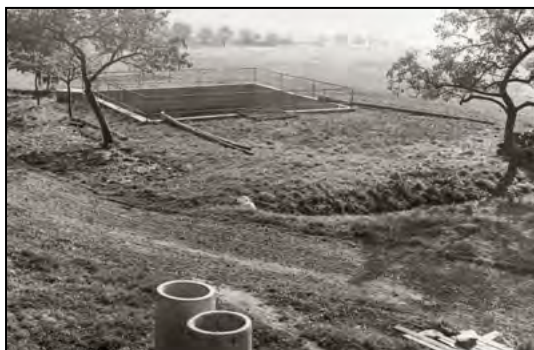
Požární nádrž na nedatovaném snímku (asi 70. léta min. st.).
