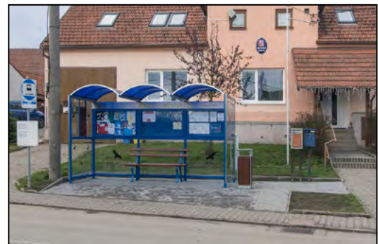
Nová zastávka před OÚ ve srovnání s předchozím stavem.
