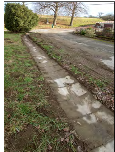
Před č.p. 63 - upravený žlab u opravené kanalizace.
