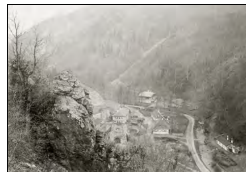
Františčina huť, kolem roku 1900. Na protějším svahu je patrné koryto na spouštění rudy vytěžené u Babic dolů do údolí.
