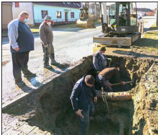
Oprava havárie vodovodního řadu u domu č. p. 29. Foto Jaroslav Luner.
