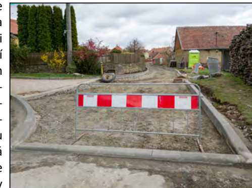
Z průběhu rekonstrukce místní komunikace vedoucí ke Klevetnici.
